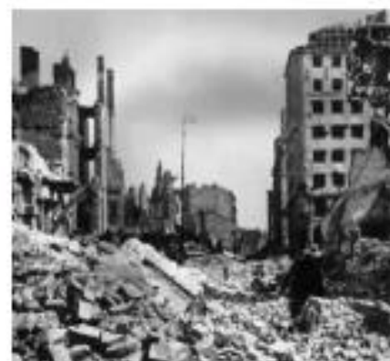
Баррикада из обломков здания
